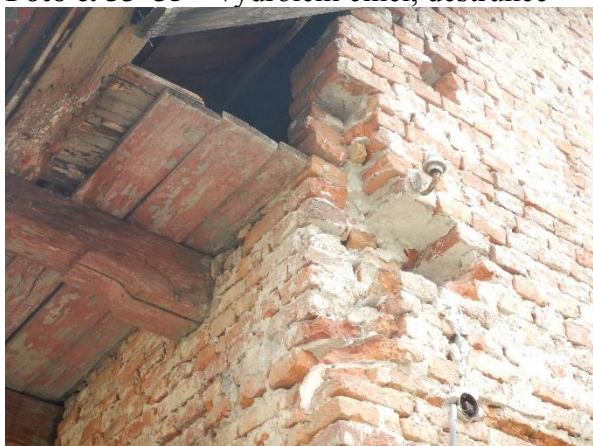
Foto č. 33–35 – vydrolení cihel, destrukce
