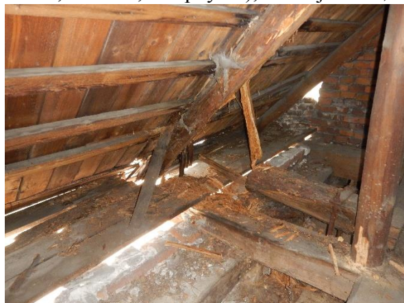
Foto č. 13 a 14 - krov 4-5 EG - rozpad prvků (krokve, pozednice, sloupky ...), havarijní stav,
