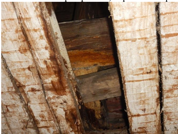
Foto č. 40 – rozpad podbití, napadení stropu
