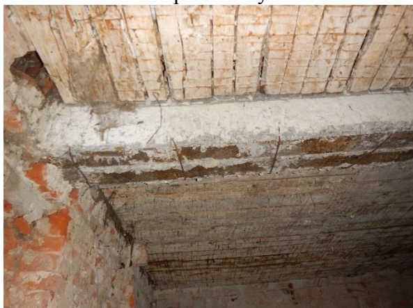
Foto č. 37 – trhlina ve vrcholu klenby
