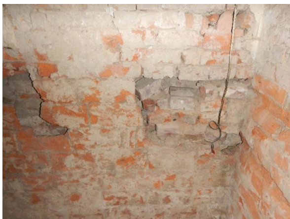
Foto č. 48 – rozpadání cihelného zdiva
