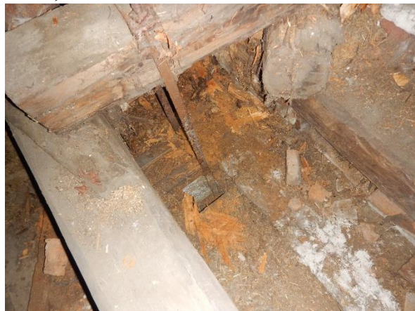
Foto č. 11 a 12 - krov 1-4 EG – rozpad prvků (krokve, krátkata, sloupky ...), havarijní stav,
