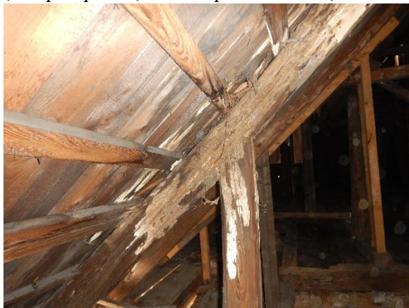
Foto č. 19 a 20 - krov 6-8 EG – rozpad prvků (krokve, krátkata, sloupky ...), havarijný stav,
