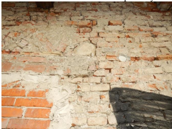
Foto č. 37–39 – charakteristické příklady trhlin ve zdivu
