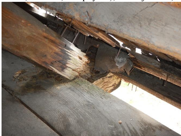
Foto č. 21 - krov 3-7 B – pozednice – napadení Foto č. 22 - krov 6 AE – VT - napadení
