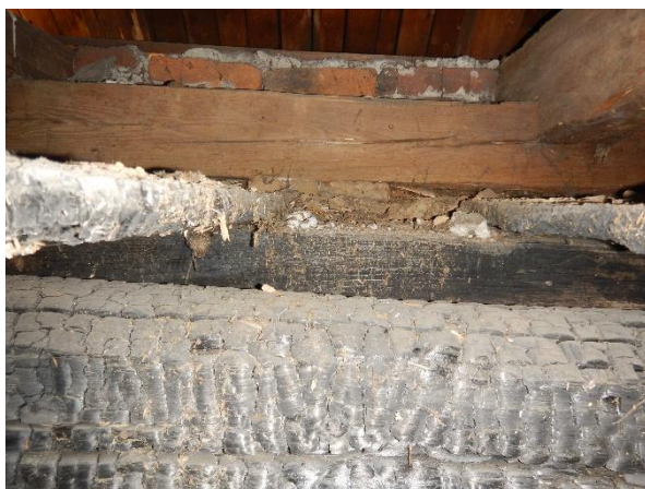
Foto č. 5 a 6 - sonda NV 2 – celkový pohled na sonda a detaily rozpadu dřev. trámu,
