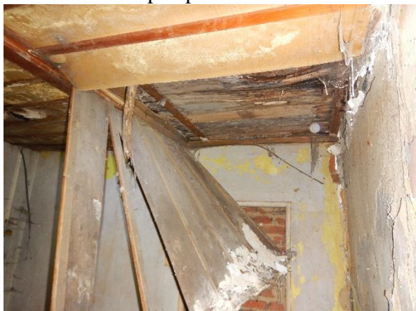
Foto č. 35 a 36 – opadání krycích bet. vrstev ocelových nosníků, koroze
