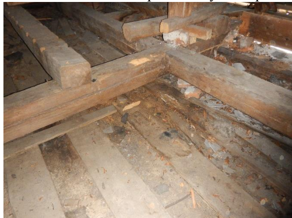
Foto č. 29-32 - krov – překládaný záklop na několika místech chybí, nap. dřevokaz. činiteli
