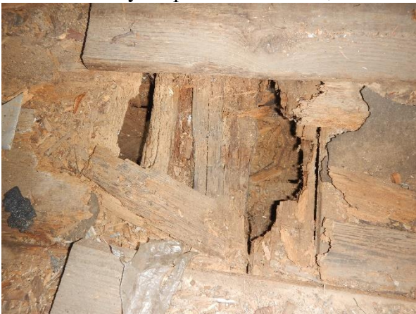
Foto č. 5 a 6 - sonda NV 2 – celkový pohled na sonda a detaily rozpadu dřev. trámu,
