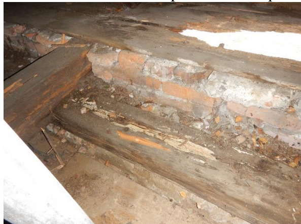
Foto č. 23 - krov 6 D – aktiv. zatékání
