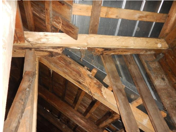
Foto č. 15 a 16 - krov 6 DG - rozpad prvků (krokve, pozednice, vazný trám...),havarijní stav,
