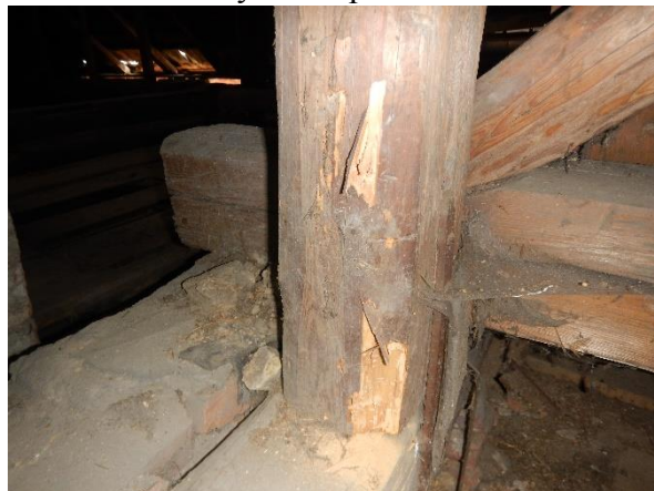
Foto č. 27 a 28 - krov 7-8 CD – aktivní zatékání, rozpad 3. krokve, hambálku a bednění
