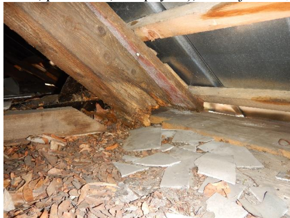
Foto č. 15 a 16 - krov 6 DG - rozpad prvků (krokve, pozednice, vazný trám...),havarijní stav,
