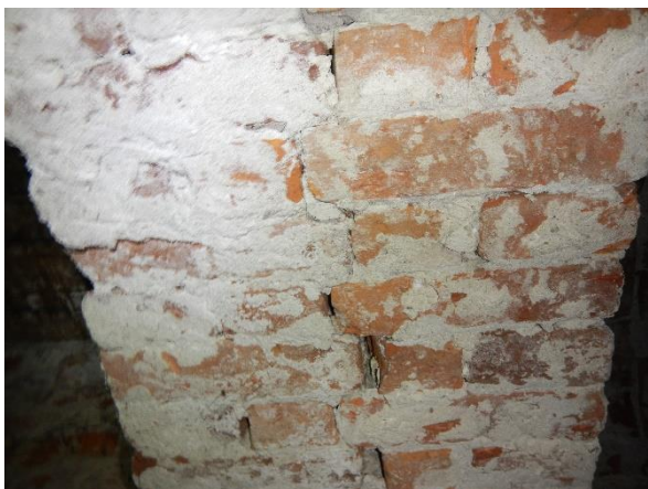
Foto č. 40 – rozpad podbití, napadení stropu
