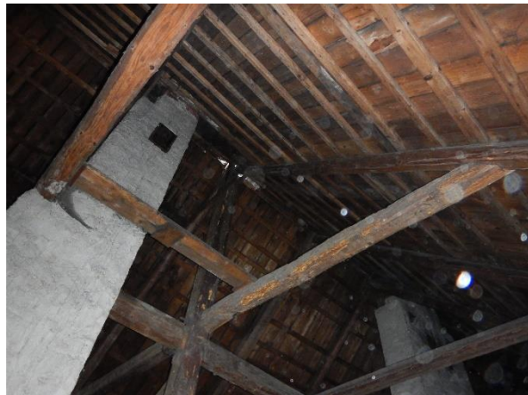
Foto č. 23 - krov 6 D – aktiv. zatékání
