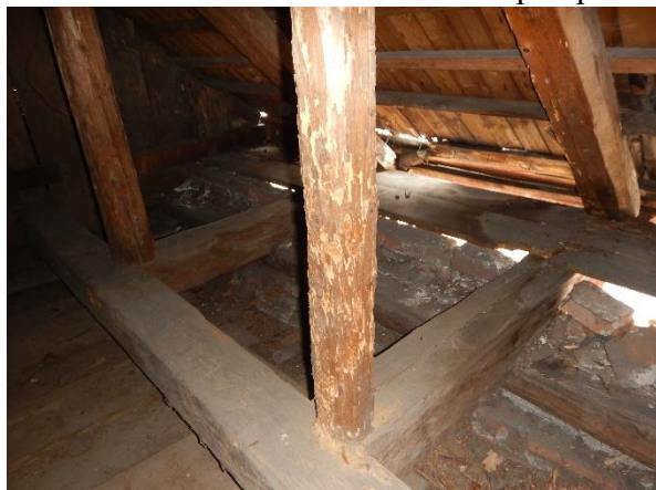
Foto č. 21 - krov 3-7 B – pozednice – napadení Foto č. 22 - krov 6 AE – VT - napadení
