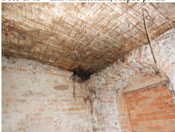
Foto č. 43 – vybouraný otvor, chyb. překlady
