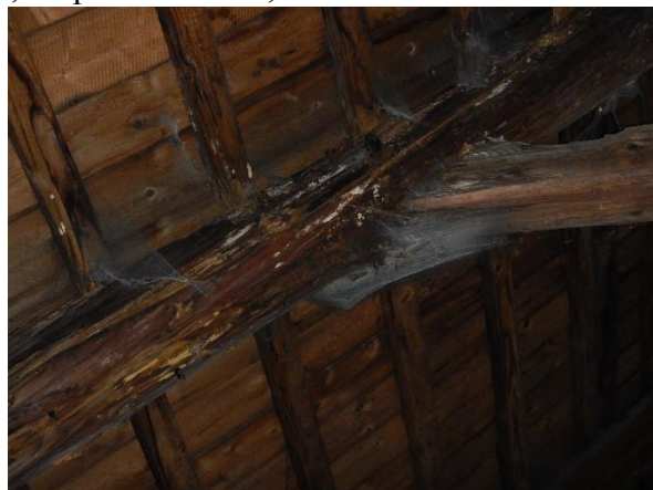
Foto č. 29-32 - krov – překládaný záklop na několika místech chybí, nap. dřevokaz. činiteli
