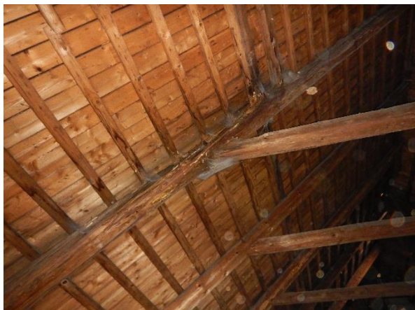
Foto č. 29-32 - krov – překládaný záklop na několika místech chybí, nap. dřevokaz. činiteli
