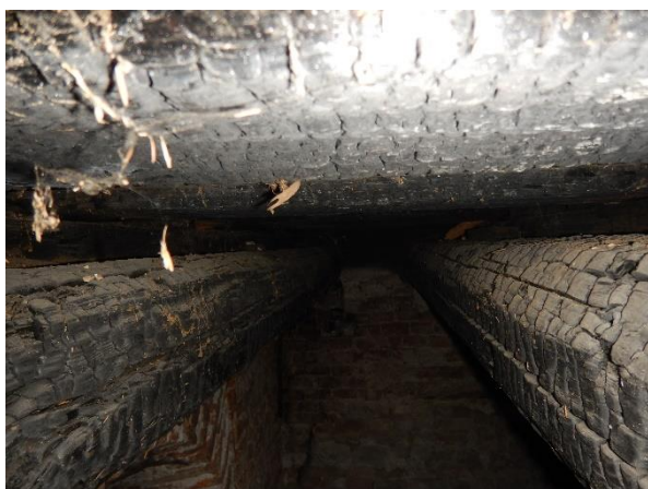
Foto č. 5 a 6 - sonda NV 2 – celkový pohled na sonda a detaily rozpadu dřev. trámu,
