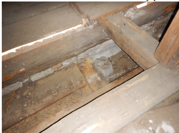
Foto č. 11 a 12 - krov 1-4 EG – rozpad prvků (krokve, krátkata, sloupky ...), havarijní stav,
