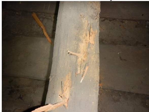
Foto č. 24 - krov 8-9 EG – lokalita napadení
