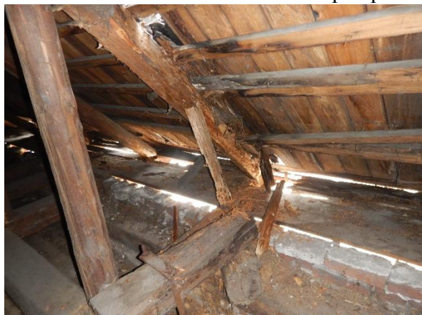
Foto č. 13 a 14 - krov 4-5 EG - rozpad prvků (krokve, pozednice, sloupky ...), havarijní stav,
