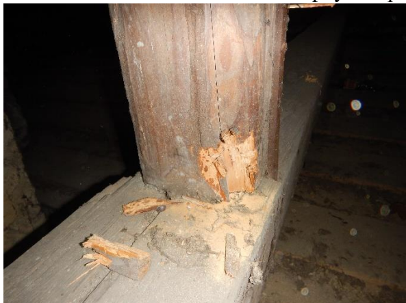
Foto č. 27 a 28 - krov 7-8 CD – aktivní zatékání, rozpad 3. krokve, hambálku a bednění
