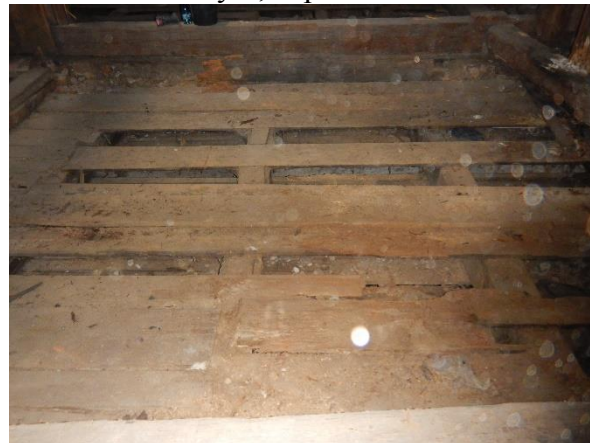
Foto č. 29-32 - krov – překládaný záklop na několika místech chybí, nap. dřevokaz. činiteli
