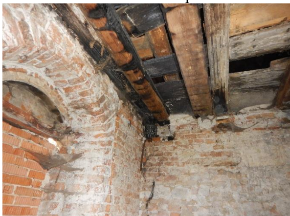
Foto č. 39 – ohořelá část stropní konstrukce
