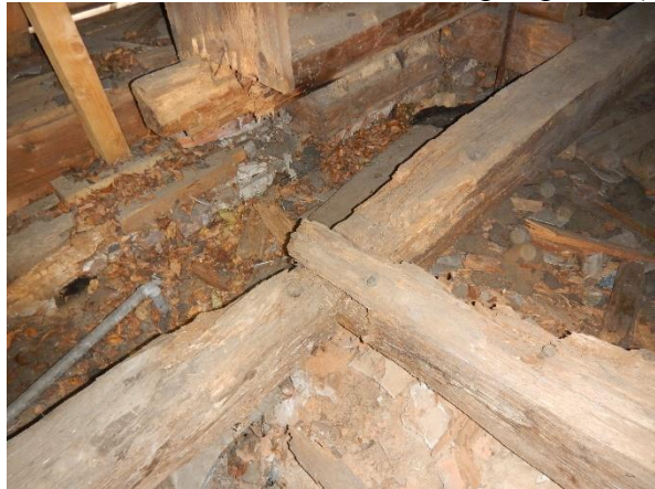
Foto č. 15 a 16 - krov 6 DG - rozpad prvků (krokve, pozednice, vazný trám...),havarijní stav,
