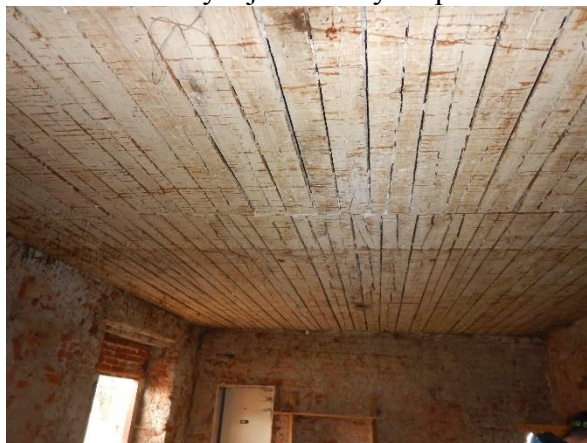
Foto č. 35 a 36 – opadání krycích bet. vrstev ocelových nosníků, koroze
