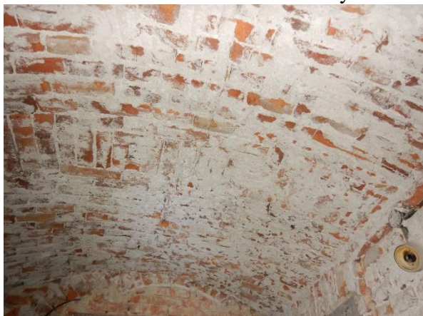
Foto č. 39 – ohořelá část stropní konstrukce
