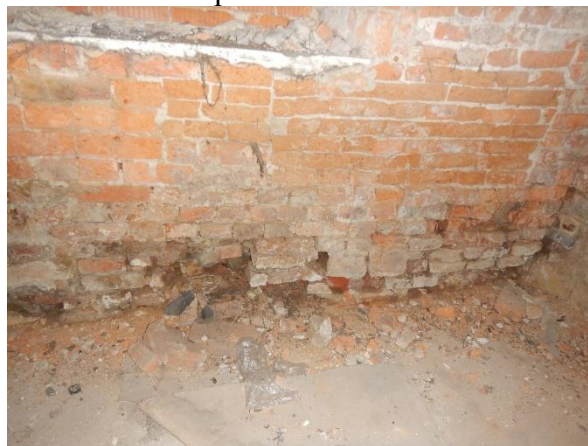
Foto č. 48 – rozpadání cihelného zdiva
